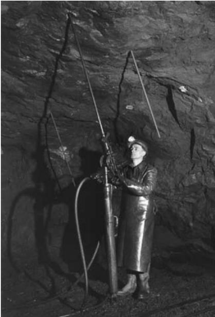
sollte. Die Bohrkronen rutschten dann oft ab und es war schwer, die Bohrlöcher exakt an den Stellen anzusetzen, die das Bohrschema vorsah. Die oberen 80 cm wurden deshalb stehen gelassen und durch eine Reihe horizontaler Sprengbohrlöcher nachträglich herein gewonnen. Damit war eine glattere Firste herstellbar.
