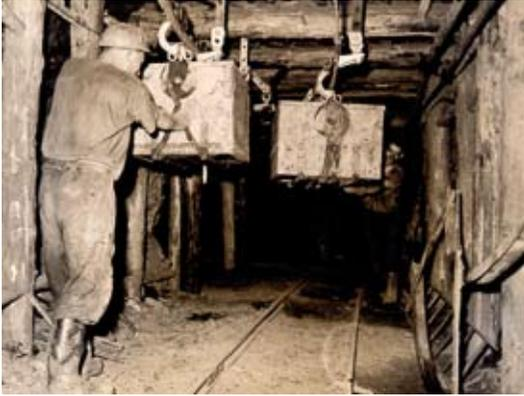
**Abbildung 8.4.5.d: Hauer Bollmann und Hauer Luft mit Einschienenhängebahn für den Versattransport zur Schleuderversatzmaschine /Sammlung Heinrich Stöcker/**
