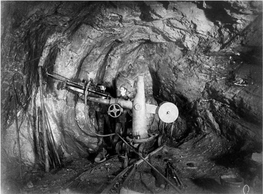
**Abbildung 5.3.d: Bohrmaschine auf gleisgebundenem Fahrwerk, Rammelsberg um 1875 /Sammlung Heinrich Stöcker/**
