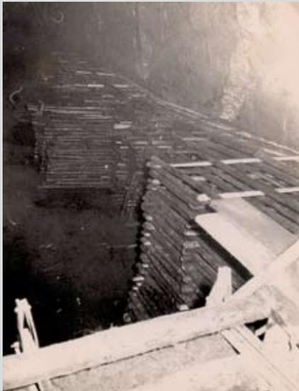
**Abbildung 8.1.d: Holzkästen zur Kammerwandstabilisierung. etwa 1965 /Sammlung Heinrich Stöcker/ Später stellte sich heraus, dass der Versatz auch ohne Holzschränke stabil blieb, wenn der benachbarter Pfeiler abgebaut wurde.**
