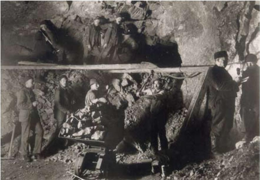
**Abbildung 8.2:** Bergleute, die zum Bohren der Sprenglöcher auf einem Holzgerüst, auf der Versatzböschung stehen, oben links Obersteiger Eduard Karl Pfaff, etwa 1890 /Sammlung Heinrich Stöcker/
