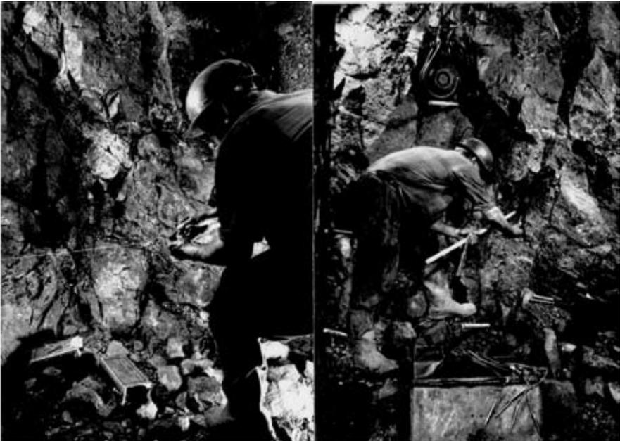
**Abbildung 5.3.q:** Hauer Heiner Nörenberg beim Bohrlochladen mit patroniertem Sprengstoff und Vorbereiten der elektrischen Zündung, etwa 1975 /Sammlung Heinrich Stöcker/
