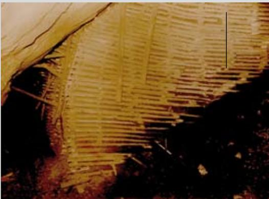
**Abbildung 8.1.c: Holzschrank mit Verformung durch Druckbelastung, Rammelsberg, 1930er Jahre /Sammlung Heinrich Stöcker/**
