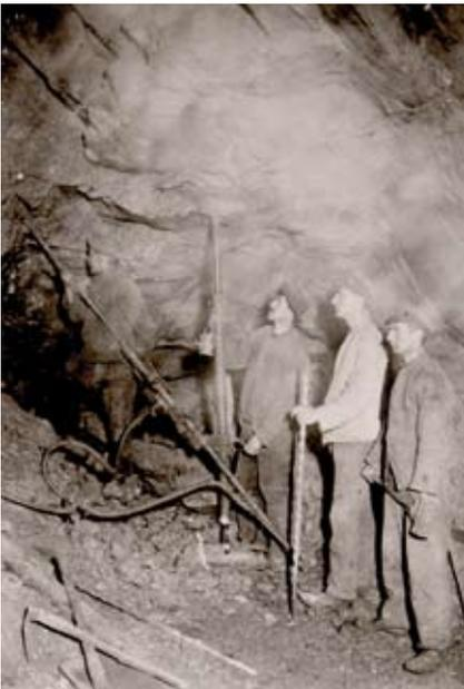
reihen mit 0,8 Meter Abstand. Damit wurde die gesamte Scheibenhöhe von 3,2 Meter Höhe in einem Abschnitt herein gewonnen. Das konnte in einem Abschlag geschehen, aber auch in mehreren Abschlügen.
