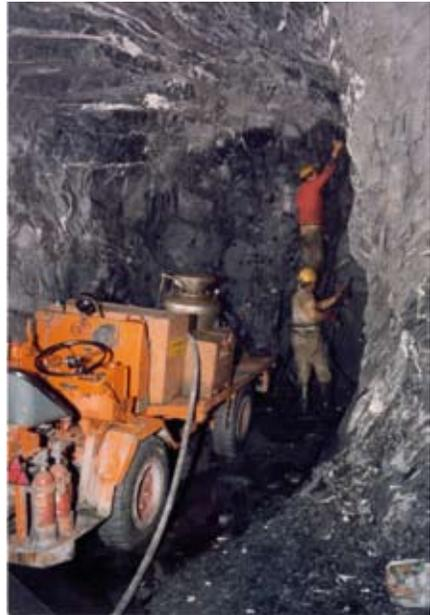
**Abbildung 5.3.s:** Einblasen losen Sprengstoffs mit einem Schell-Sprengfahrzeug /Sammlung Heinrich Stöcker/
