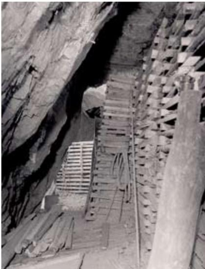
**Abbildung 4.5.c: Stoßbau, Verhieb-richtung nach ONO. Blick nach WSW durch den offenen Abbauhohlraum / Sammlung H. Stöcker/; links oben: Erzstoß; rechts: Versatzschranken; Bildmitte: Versatzböschung und darüber erleuchtete Versatzstrecke**
