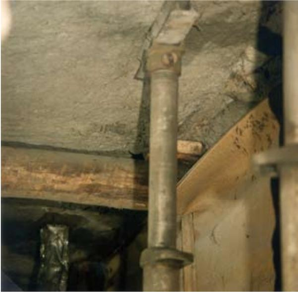
**Abbildung 8.6.3.d:** Ausbau mit Hydraulikstempeln und kurzen Kappen
