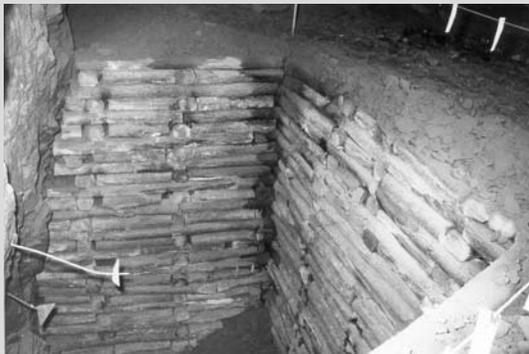
**Abbildung 8.1.e: Holzschränke zur Stabilisierung der Umgebung eines Rollochs, das aus dem noch nicht abgebauten Pfeiler heraus in den Versatz der Kammern geführt wurde /Sammlung Heinrich Stöcker/**
