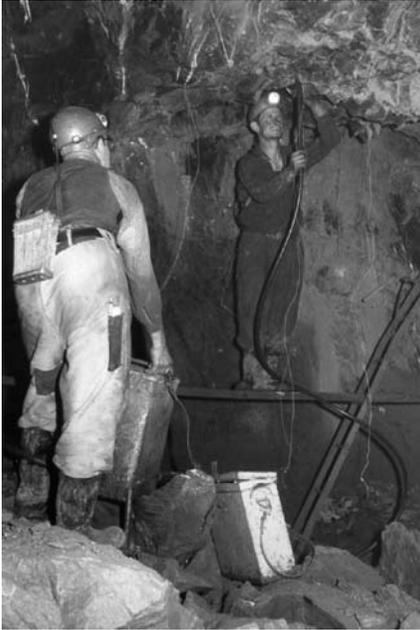
**Abbildung 5.3.r:** Erwin Heise und Henry Luft etwa 1975 beim Bohrlochladen mit losem Sprengstoff /Sammlung H. Stöcker/
