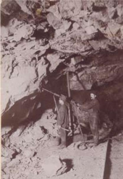
**Abbildung 5.3.e: Säulenbohrmaschine, Rammelsberg um 1905 /Sammlung Heinrich Stöcker/**
