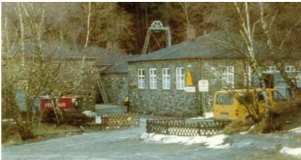
**Abb. 7.2.a: Hilfsfördergerüst für Schachtverfüllung, 1997. Foto von Richard Bothe**
