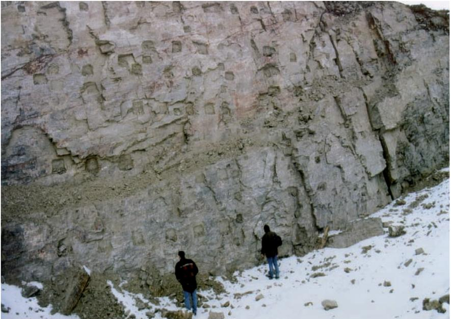
**Abb. 3.1.4.b und c: Bühnlöcher in Erztagebauwand, Prinzler Gangzug, Tagebau am Sauberg in Ehrenfriedersdorf. Im Bild Jens Pfeifer und der Verfasser, Fotos von Volkmar Scholz 2004**
