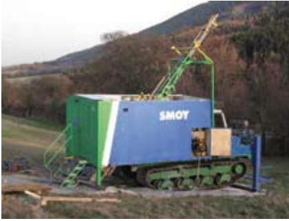
Abbildung 6.8.c: Bohranlage der Harz Minerals, Bohrfirma SMOY im Gosetal /WAL 2011/
