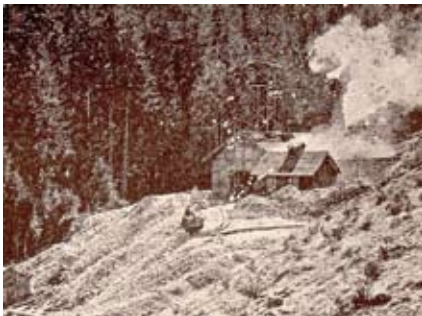
Abbildung 6.3.3.f: Tagesanlagen der Grube Großfürstin Alexandra im Jahre 1895, /BEH 1915/
