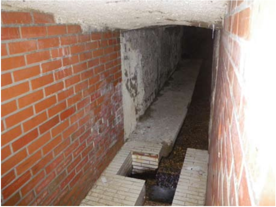
6.3.3.j: Wasserfassungsbauwerk im Stollens der Grube Großfürstin Alexandra, Foto Peter Eichhorn 2011
