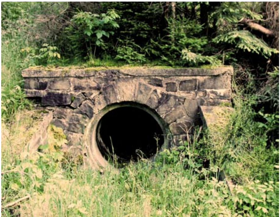
Abbildung 6.3.2.f: Heutiges Mundloch des Unteren Stollens der Grube Weißer Hirsch, Foto Peter Eichhorn 2009
