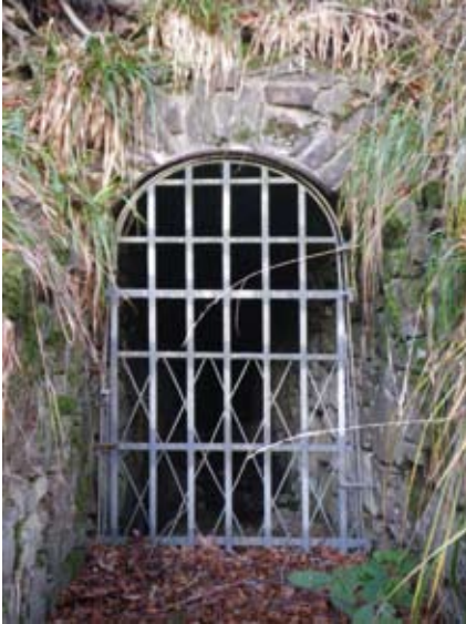
Abbildung 6.3.4.g: Grube Bakenberg, Stollenmundloch, Foto Peter Eichhorn 2011
