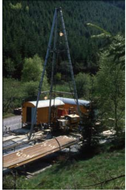
Abbildung 6.7.i: Bohrung Gelmketal 1 nach dem Betonieren, Foto Eckart Walcher
