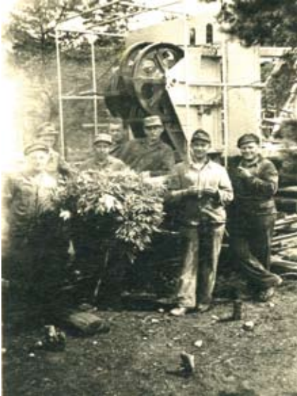
Abbildung 6.6.f.4: Turmaufbau. Baukolonne mit Richtkranz, der vor dem Aufrichten des Turms im Bereich der oberen Rolle befestigt wurde.
