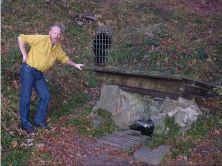
Abbildung 6.3.4.f: Grube Bakenberg, Stollenmundloch, im Vordergrund Peter Eichhorn an der Wasserableitung, Foto Silke Svea Eichhorn 2011
