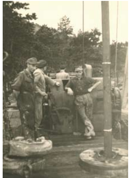
Abbildung 6.6.f.9: Bohranfang, am Bohrgestänge sind zwei Markierungen, die untere kennzeichnet den ersten Bohrmeter
