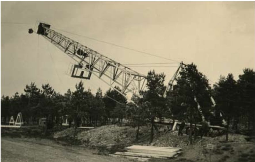
Abbildung 6.6.f.5: Turm wird begonnen aufzurichten.
