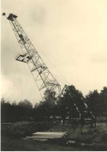
Abbildung 6.6.f.6: Turm beinahe aufgerichtet.
