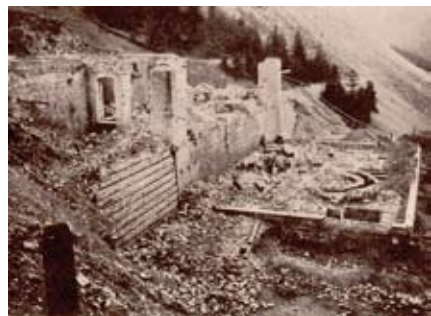
6.3.3.g: Ruinen der Tagesanlagen der Grube Großfürstin Alexandra im Jahre 1914 /BEH 1915/
