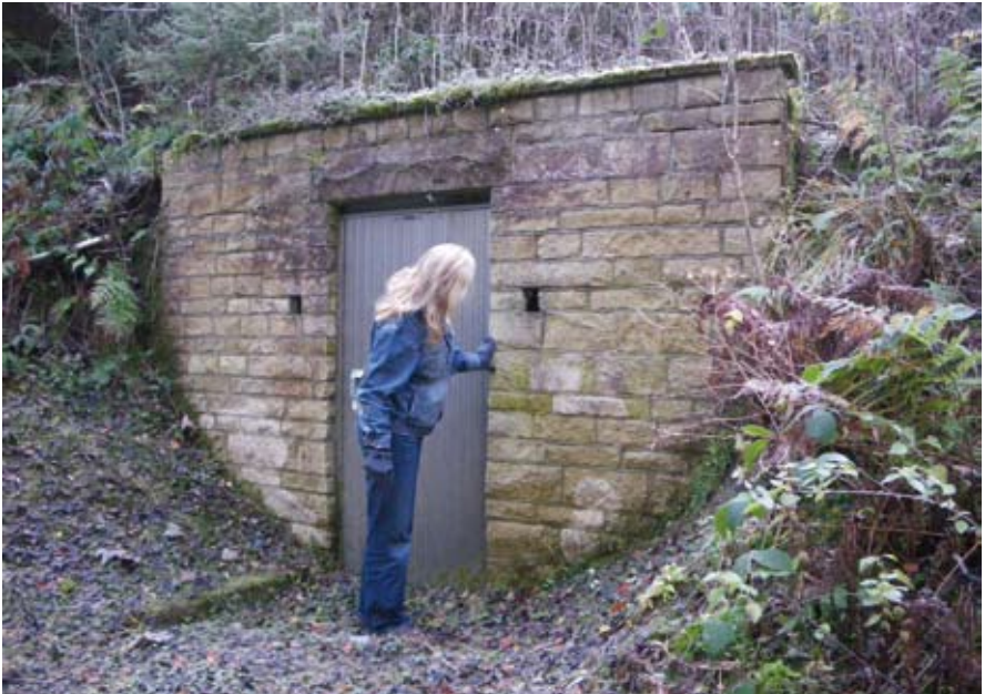
6.3.3.i: Stollenmundloch des Wasserlösungsstollens der Grube Großfürstin Alexandra, im Vordergrund Silke Svea Eichhorn, Foto Peter Eichhorn 2011
