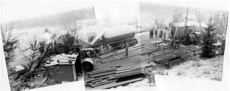
Abbildung 6.7.h: Bohrung Gelmketal 1 beim Betonieren, Foto Eckart Walcher
