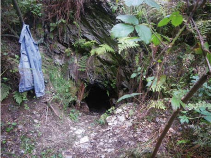
Abbildung 6.3.4.d: Stollenmundloch des Dröhneberg-Stollens, Foto Peter Eichhorn 2011
