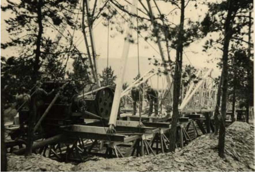
Abbildung 6.6.f.2: Turmkonstruktion Bohrung Rammelsberg 5, Turm liegt noch, Lauffläche vom Maschinenhaus wird montiert.
