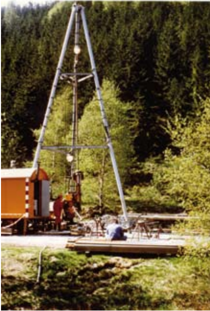
Abbildung 6.7.j: Bohrung Gelmketal 1 nach dem Betonieren, Foto Eckart Walcher
