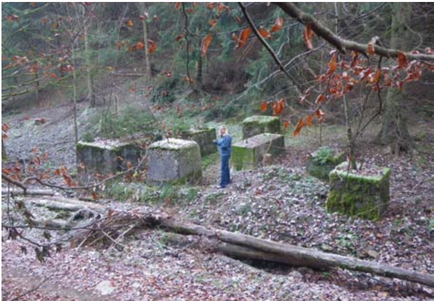
Abbildung 6.6.f.1: Betonfundamente für die Bohrung Dörpketal. Daraus aufbauend war der Turm Segment für Segment montiert worden. Foto Peter Eichhorn 2011
