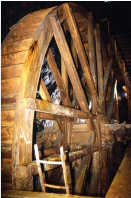
Abb. 4.2.5: Hölzerner Stempel unter der Welle des Oberen Serenissimum Kunstrades (rechts unten im Bild). Foto von Holger Lausch
