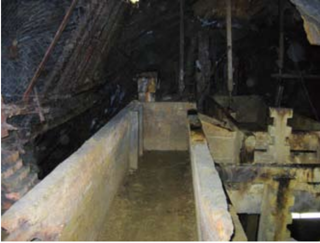
Abb. 4.4.2.a: Stahlträger zur Firstsicherung der Serenissimum Kehrradstube (links), in der Mitte der Zulauf zum Wasserkasten, rechts die östliche Kuppelstangen (bislang nicht komplettiert). Foto von Peter Mühr
