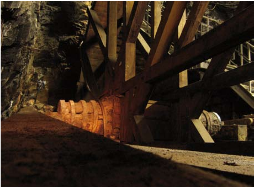
Abb. 4.4.4.b: Obere Serenissimum Kunstradstube, Südwestwand. Gestänge (links unten im Vordergrund), Grundrahmen (rechts daneben) und neue Lichtgitterrost-treppe (im Hintergrund), Foto von Peter Mühr
