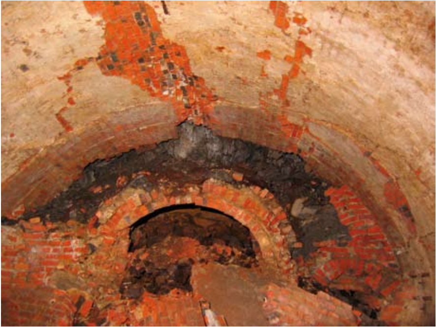
Abb. 3.3.h: Firste des ehemaligen Förderhaspelraums vom Serenissimum Schacht. Foto von Peter Mühr
