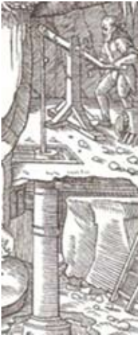
Abb. 3.1.b: Handhubkolbenpumpe. Abbildung aus De re metallica von Georgius Agricola
