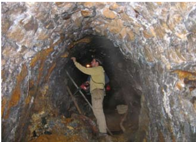
Abb. 4.5.d: Fördervereinsmitglied Andreas Faulwasser beim Einbau der Beleuchtungsanlage in der Serenissimum Gestängestrecke. Foto von Peter Mühr
