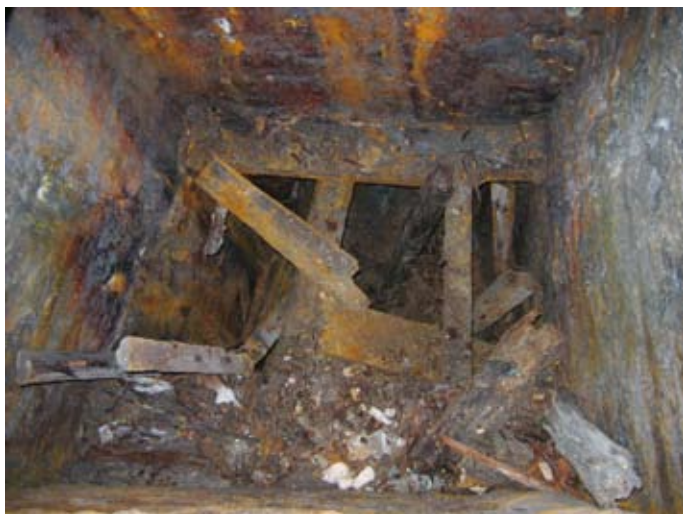
Abb. 4.6.b: Blick von oben in das Schützerort Kanekuhler Schacht. Foto Peter Mühr
