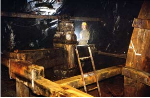
Abb. 4.4.4.a: Obere Serenissimum Kunst- radstube. Grundrahmen (mit daran angelehnter Stahlfahrt), Gestänge (links unten) und Ste- hendes Kunstkreuz. Foto von Holger Lausch
