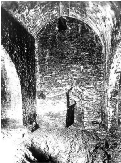
Abb. 3.1.f: Feuerzähler Schacht (unten) und Feuerzähler Gewölbe 1928. Foto aus der Sammlung Heinrich Stöcker
