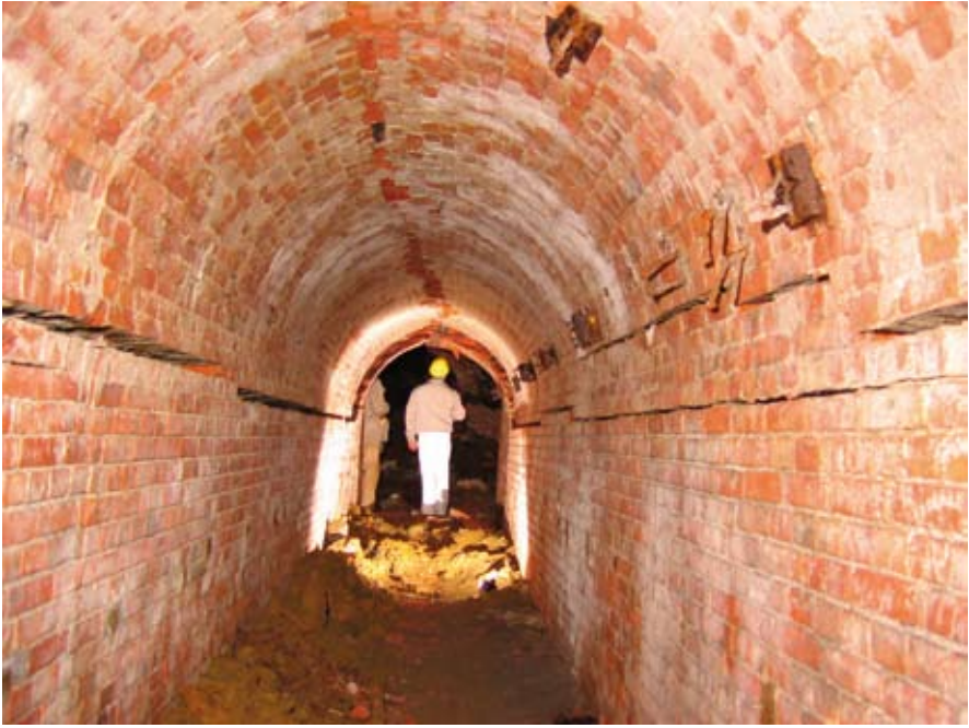
Abb. 3.3.g: Zugang zum ehemaligen Förderhaspelraum vom Serenissimum Schacht. Foto von Peter Mühr
