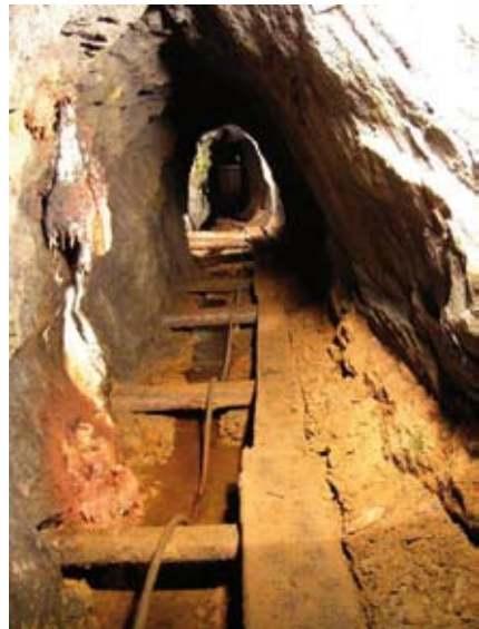
Abb. 4.2.2.c: Gerinne im Ersten Was- serlauf kurz vor der Kanekuhler Kehrradstube. Foto von Peter Mühr
