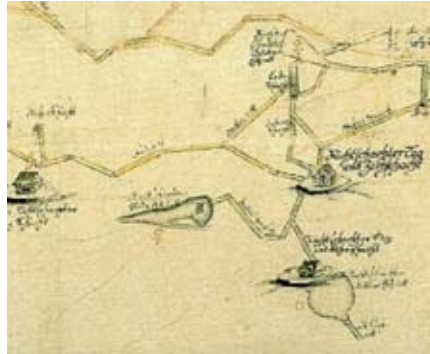
Abb. 1700.4: drei Haspelhäuser der neuen Grube Richtschacht
