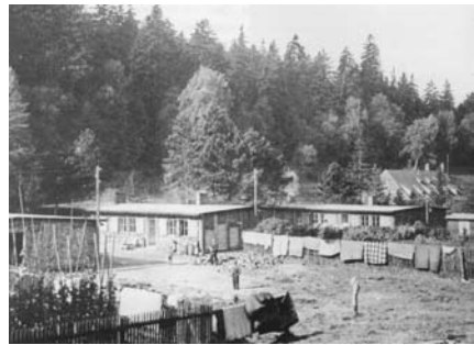
Abb. 1942.6: Barackenlager unterhalb des Herzberger Teichdamms. Foto aus der Sammlung Heinrich Stöcker
