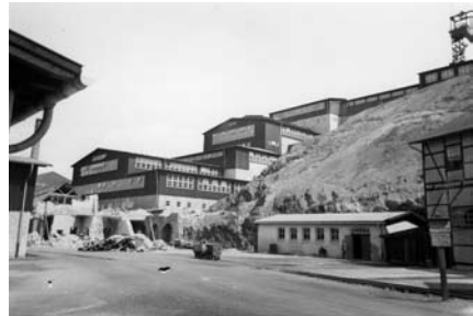
Abb. 1942.4: Flotationsanlage und Abbrucharbeiten ehem. Werkstatt. Links unter dem Fördergerüst die provisorische Kaue (mit Fachwerkfassade) und rechts daneben die Lampenstube. Foto aus der Sammlung Heinrich Stöcker
