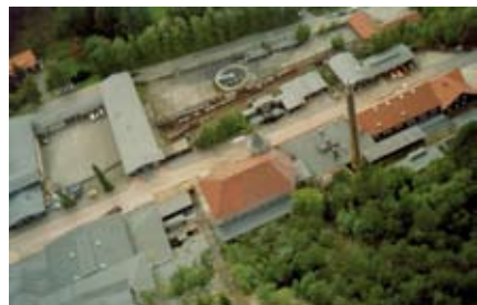
Abb. 1.3.4.3: Tagesanlagen des Rammelsbergs. Luftbild vom Verfasser aus etwa 75 m Höhe über dem Schrägaufzug. Blick nach Westen. 2008 In der Bildmitte oben ist der Cyclator als rundes Bauwerk zu erkennen.
