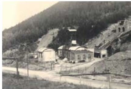
Abb. 1920.6: Tagesanlagen Winkler Wetterschacht aufgenommen mit Blick nach Nordosten. Etwa 1925. Foto aus der Sammlung Heinrich Stöcker, Rechts der untere Teil des neuen Bremsberges.
