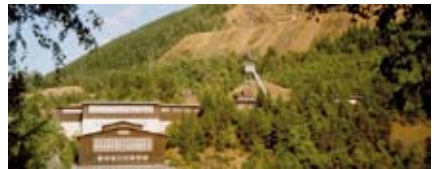
Abb. 1.3.1.12: Fördergerüst des Rammelsbergsschachtes mit Wagenumlaufhalle (links, obere Etage) und Fördermaschinenhaus (rechts, etwas verdeckt). Foto vom Verfasser 2008
