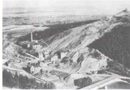
Abb. 1910.4: Tagesanlagen um 1920. Vorn rechts der Herzberger Teich, links die Berginspektion. In der Bildmitte die Sieb- und Klaubeanlage. Dahinter der Gebäudekomplex Werkstatt-Magazin-Zechenhaus-Waschkau, links dahinter Kraft-Zentrale und oben rechts der Maltermeister Turm. Foto aus der Sammlung Heinrich Stöcker
