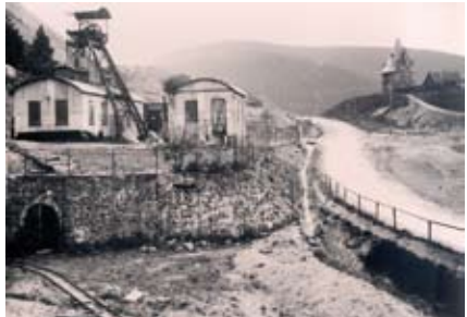
Abb. 1920.5: Tagesanlagen Winkler Wetterschacht (links) und Maltermeister Turm (rechts). Aufgenommen mit Blick nach Südwesten. Etwa 1920. Foto aus der Sammlung Heinrich Stöcker
