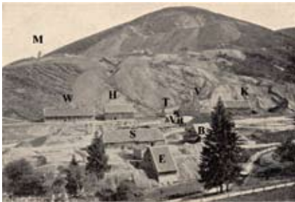
Abb. 1870.2: Gesamtansicht von Westen. Foto aus der Sammlung Heinrich Stöcker B: Brandstaubwäsche, E: Erzlager der Brandstaubwäsche, H: Holzlager, K: Kassen- und Bürohaus, M: Maltermeister Turm, S: Schmiede, T: Teerhaus, V: Vorhaus der Tagesförderstrecke, Vit: Vitriollagerhäuser, W: Werkstatt
