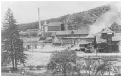
Abb. 1920.3: Tagesanlagen um 1925. Vorn rechts Flotations-Versuchsanstalt mit hölzernem Kühlturm, in der Mitte der Gebäudekomplex Werkstatt-Magazin-Zechenhaus, dahinter die Kraft-Zentrale. Foto aus der Sammlung Heinrich Stöcker
