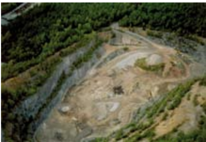
Abb. 2000.5: Schiefermühlenverfüllung Stand 2008. Luftbild vom Verfasser
