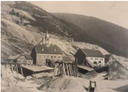
Abb. 1850.3: Teerhaus (links), Vorhaus (großes Gebäude in der Bildmitte), Bürohaus (rechts, hier schon mit Obergeschoss), Einfahrtschacht (dahinter) und Wohnhaus von Kunststeiger und Kunstknecht (rechts). Foto aus der zweiten Hälfte des 19. Jhd., Sammlung Heinrich Stöcker
