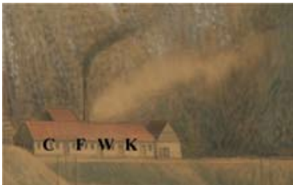
Abb. 1.3.5.1: Gebäude auf dem Kanekuhler Schacht. Ausschnitt aus einem Gemälde von Wilhelm Riepe. 1877. Sammlung Rammelsberger Bergbaumuseum. Foto von Stefanie Kammer. 2008. In dem langgestreckten Gebäude befanden sich neben dem „Luft-Compressor“ (C) eine Fördermaschine (F), eine Wasserhaltungsmaschine (W) und die Dampfkessel (K).
