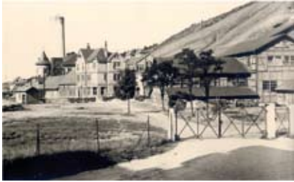
Abb. 1920.2: Tagesanlagen um das Jahr 1920 von Süden gesehen. Vorn links die Sieb- und Klaubeanlage, Bildmitte: nördliches Verwaltungsgebäude (Zechenhaus), dahinter die Kraft-Zentrale. Foto aus der Sammlung Heinrich Stöcker
