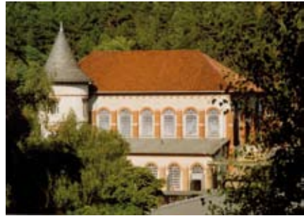
Abb. 1.3.5.5: Kraft-Zentrale, heute Energiezentrale genannt. Foto vom Verfasser. 2008
