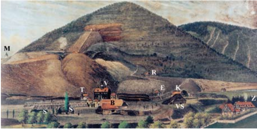
Abb. 1850.2: Gesamtansicht von 1837 von C. Rosenbaum. Das Kassen- und Bürogebäude scheint kurze Zeit später gebaut worden zu sein, denn rechts neben dem Vorhaus sind an der Böschung bereits Spuren vorbereitender Arbeiten zu erkennen. Die Dampfwolke steht über einem der ausziehenden Wetterschächte. B: Brandstaubwäsche, E: Einfahrtschacht, K: Kunststeigerhaus, M: Maltermeister Turm, R: Rathstiefster Schacht, S: Schmieden, T: Teerhaus, Vit: Vitriollagerhäuser, V: Vorhaus der Tagesförderstrecke, VS: Vorratsschuppen, Z: Zechenhaus
