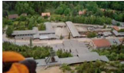
Abb. 1.3.3.6: Dächer der Flotationsaufbereitung zwischen dem Fördergerüst Rammelsbergschacht und der im Bild quer verlaufenden Werksstraße. Luftbild vom Verfasser. 2008 Blick von einer Position etwa 100 m über der Schiefermühle. Links unscharf im Vordergrund ein Handschuh des Verfassers. Rechts mit großem roten Dach die Energiezentrale. Hinter der Werksstraße (von links nach rechts) die Kau, die Lohnhalle, der untere Werkshof mit Verwaltungs- und Magazingebäude. Weiter rechts der Cyclator, die Mammutpumpenanlage, Bohrerschmiede und die Wagenreparaturwerkstatt.
