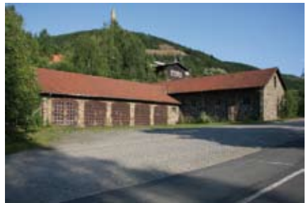
Abb. 1950.5: Garagen an der Rammelsberger Straße. Foto von Ulrich Kammer. 2008
