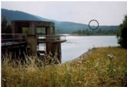
Abb. 1.3.4.5: Auslaufbauwerk am unteren Absetzteich Gelmketal. Foto vom Verfasser. 2008. Blick nach Westen. Am Horizont der Turm der Aufbereitungsanlage Bollrich.
