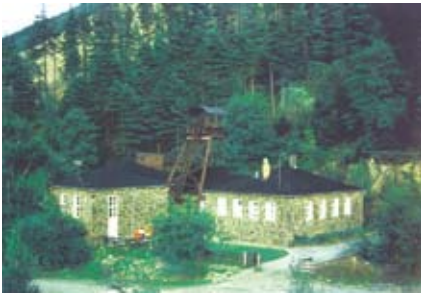
Abb. 1.3.1.14: Fördergerüst und Tagesanlagen des Winkler Wetterschachtes um 1970. Foto aus der Sammlung Heinrich Stöcker
