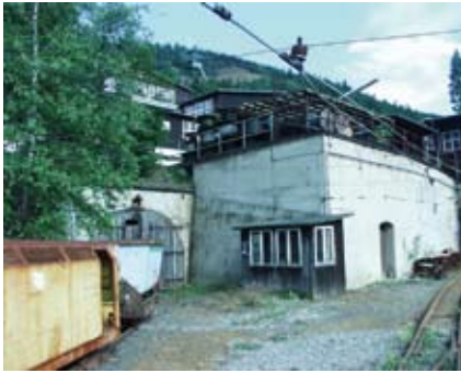
Abb. 69: Konzentratverladung unter dem Erzaufbereitungsgebäude. Heutiger Zustand, Aufnahme des Verfassers. Links: großes Tor des neuen Mundlochs. Rechts: kleinere Tür. Dort lag etwa das ursprüngliche Mundloch.
