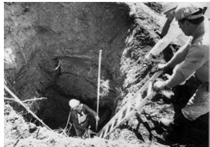
Abb. 29: Ältester Wasserableitungsstollen, Heinrich Stöcker 1978 während der Befahrung des Tagebruchs. Foto aus der Sammlung Heinrich Stöcker
