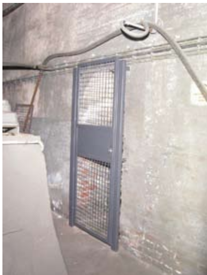
Abb. 125: Umspannwerk 2, Zugangsstollen von der Mühlenbühne des Aufbereitungsgebäudes. Foto Peter Mühr 2007
