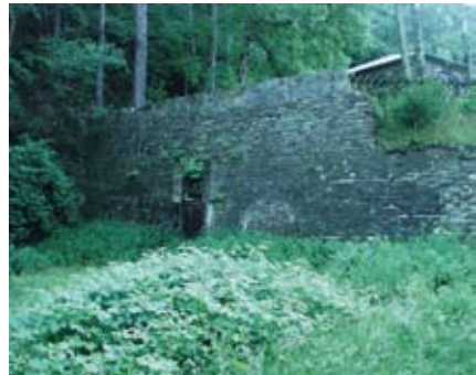
Abb. 142: Winkler Wetterschacht, Mundlöcher am nordöstlichen Vorplatz des Winkler Wetterschachtes Südseite. Links: Rolllochschnauze mit Stahlplatte verschlossen. Rechts: niedriges Mundloch mit gewölbter Natursteinausmauerung. Rechts oben im Bild: Tagesanlagen des Winkler Wetterschachtes, heutiger Zustand. Aufnahme des Verfassers
