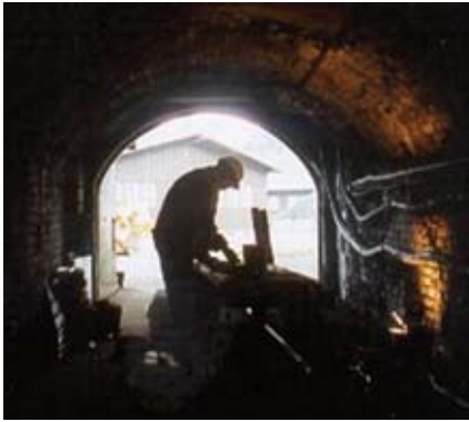
Abb. 5: Tagesförderstrecke. Wolfgang Kotzaneck bei der Mauerwerksanierung im Mundlochbereich 2006, Aufnahme des Verfassers
