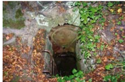
Abb. 110: Tiefer Julius Fortunatusstollen, Blick von oben auf die Stahlleiter, die hinab führt in den Graben vor dem Mundloch und zum Stahltor des Mundloches. Foto Jens Kugler 2006
