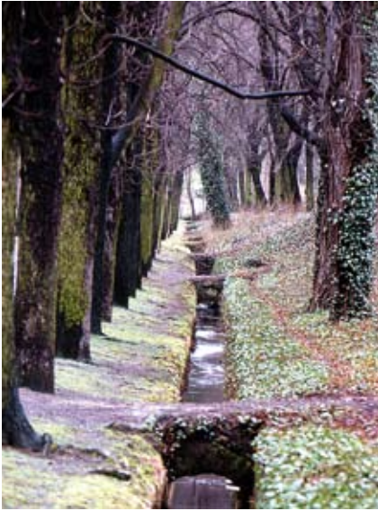
Abb. 111: Tiefer Julius Fortunatusstollen, Graben vor dem Mundloch, im Hintergrund das Mundloch. Foto Jens Kugler 2006
