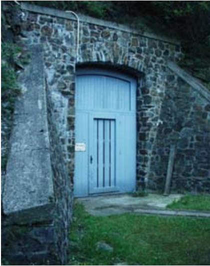
Abb. 123: Umspannwerk 2. Hauptzugangsstollen nördlich vom Schrägaufzug hinter der Energiezentrale, heutiger Zustand, Aufnahme des Verfassers
