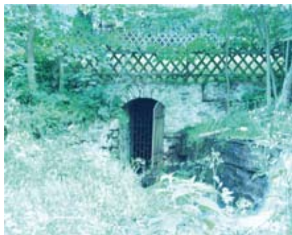
Abb. 83: Rathstiefster Stollen, Mundloch, heutiger Zustand, Aufnahme des Verfassers
