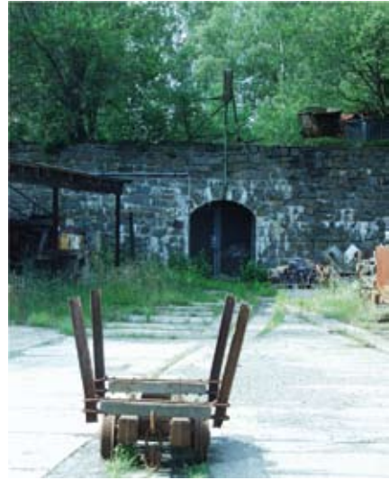
Abb. 63: Karbidstollen, Mundloch, heutiger Zustand, Aufnahme des Verfassers
