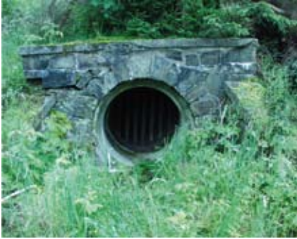
Abb. 134: Grube Weißer Hirsch, Neues Mundloch vor der Betonröhre zum Unteren Stollen, heutiger Zustand. Aufnahme des Verfassers
