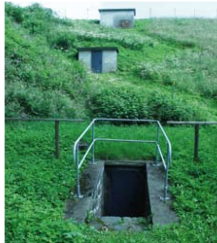
Abb. 85: Revisionsstollen im bzw. am Herzberger Teichdamm, heutiger Zustand, Aufnahme des Verfassers. Oben (Nähe Teichdammkrone): Zugang zur Entlüftungsanlage der Heberleitung. Mitte: Zugang zum Wasserschloss der Heberleitung, unten (unterhalb des Teichdammfußes): der Brauck
