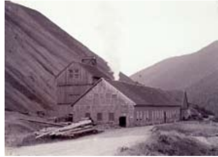
Abb. 37: Kanekuhler Schacht, Tagesanlagen um 1900. Foto aus der Sammlung Heinrich Stöcker
