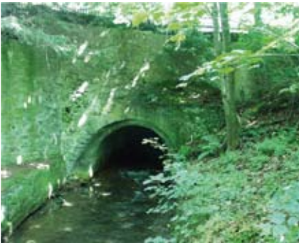
Abb. 26: Auslaufbauwerk der abgedeckten Abzucht, heutiger Zustand, Aufnahme des Verfassers
