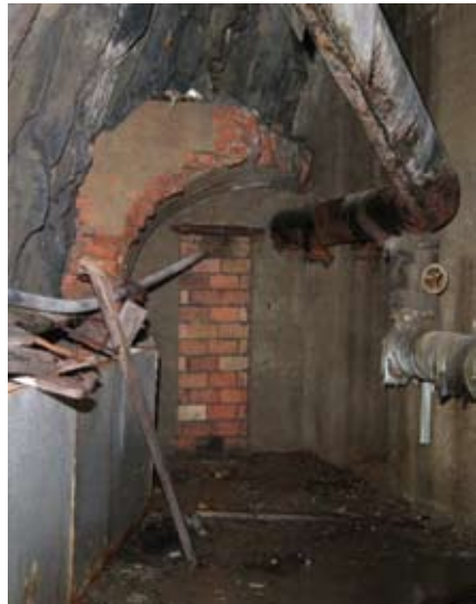
Abb. 49: Gabelstrecke Reste der Ausbaumauerung in der Eindickerebene der Aufbereitungsanlage. Foto Peter Mühr 2007
