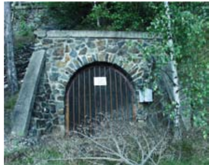
Abb. 124: Umspannwerk 2. Oberer Zugangsstollen südlich vom Schrägaufzug, heutiger Zustand, Aufnahme des Verfassers
