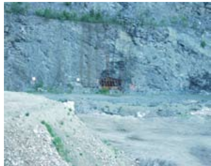
Abb. 45: Bergeschachtstrecke, Mundloch zur Siebmaschine, 2007, Aufnahme des Verfassers
