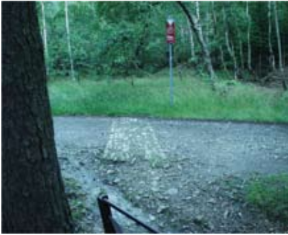
Abb. 35: Ascheabzugsstollen vom Kesselhaus des Kanekuhler Schachtes, Forststraße über dem Stollen mit quer verlaufender Mauerung zur Firstsicherung, heutiger Zustand, Aufnahme des Verfassers
