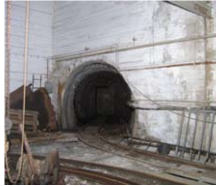
Abb. 78: Oberen Hängebankstollen, Mundloch im Wagenumlaufgebäude Rammelsbergschacht. Foto Peter Mühr 2007
