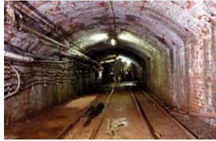
Abb. 105: Tagesförderstrecke/Richtschachtstrecke. Bahnhof am Richtschacht. Foto Stefan Dützer 1998
