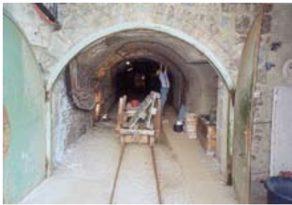
Abb. 107: Tagesförderstrecke, Sanierungsarbeiten am Mundloch-Mauerwerk durch Wolfgang Kotzaneck 2006
