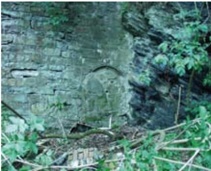
Abb. 141: Winkler Wetterschacht, kleineres der beiden Mundlöcher vom nordöstlichen Vorplatz des Winkler Wetterschachtes Nordseite mit gebogener Stahlschiene in der Firste, heutiger Zustand. Aufnahme des Verfassers
