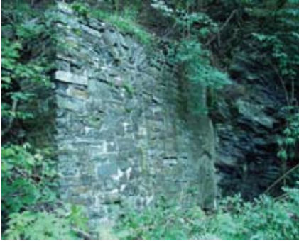
Abb. 140: Winkler Wetterschacht, abgemauerte Mundlöcher am nordöstlichen Vorplatz des Winkler Wetterschachtes, Nordostseite. Links oben in der Mauer: hohes schmales Mundloch, oben an der bogenförmig gemauerten Natursteinfirste zu erkennen. Rechts unten in der Mauer: niedriges Mundloch mit gebogener Stahlschiene in der Firste, heutiger Zustand. Aufnahme des Verfassers
