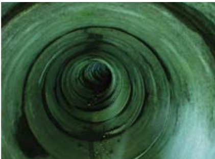
Abb. 133: Grube Weißer Hirsch, Betonröhre zum Mundloch des Unteren Stollens, heutiger Zustand. Aufnahme des Verfassers
