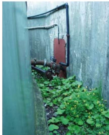
Abb. 120: Turbinenschachtstollen, Mundloch, heutiger Zustand, Aufnahme des Verfassers. Links: Wand des Eindickers, rechts: Wand unterhalb der Werkstraße
