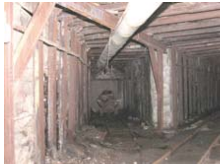
Abb. 75: Oberer Hängebankstollen, Schiefermühlenstrecke, Mundloch im Wagenumlaufgebäude Rammelsberg-schacht. Links: Umfahrung um den Schacht. Foto Peter Mühr 2007
