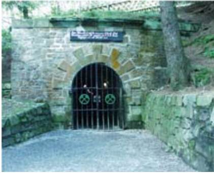
Abb. 90: Röderstollen, Mundloch , heutiger Zustand, Aufnahme des Verfassers
