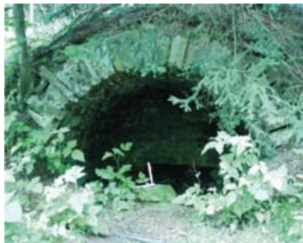
Abb. 80: Pferdetränke, Mundloch, heutiger Zustand, Aufnahme des Verfassers
