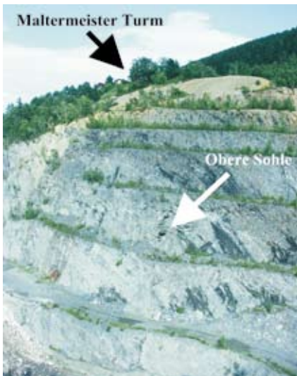
Abb. 22: Obere Sohle. Östliche Böschung der Schiefermühle mit unterhalb des Maltermeister Turms angeschnittener Strecke, heutiger Zustand, Aufnahme des Verfassers
