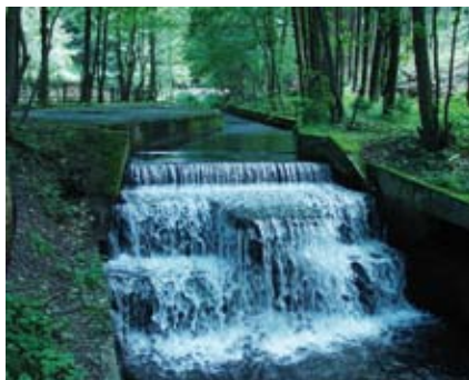
Abb. 128: Brauchwasserversorgung, Grandsumpf oberhalb des Einlaufs in den Herzberger Teich (links oben), heutiger Zustand, Aufnahme des Verfassers
