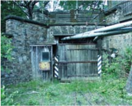
Abb. 52: Gelenbecker Stollen, Mundloch am Werksbahnhof Rammelsberg, heutiger Zustand, Aufnahme des Verfassers
