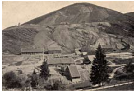
Abb. 101: Tagesförderstrecke, Tagesanlagen des Rammelsbergs mit dem unteren Werkshof. Mitte-rechts mit Türmchen das Vorhaus der Tagesförderstrecke. Foto Behme um 1890
