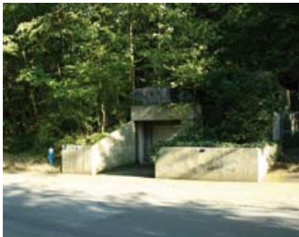
Abb. 117: Trafo-Raum am ehemaligen Verwaltungsgebäude der Preussag, Rammelsberger Straße unten. Foto Stefanie Kammer 2007
