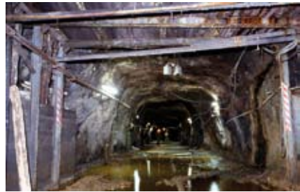
Abb. 10: Bergeschachtstrecke. Rechteckiger Stollenquerschnitt für große Frontschauffellader. Foto Holger Lausch 1998
