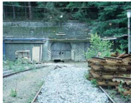
Abb. 53: Gelenbecker Stollen, Mundloch am Werksbahnhof Bollrich, heutiger Zustand, Aufnahme des Verfassers
