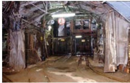
Abb. 100: Füllort Richtschacht Tagesförderstrecke, Foto Holger Lausch 1998
