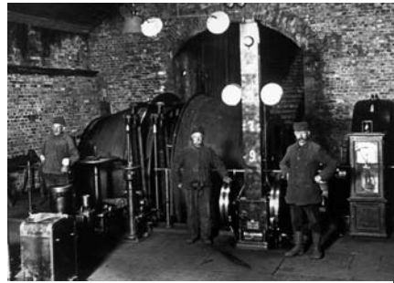
Abb. 84: Richtschachtfördermaschine von 1910, Fotos aus der Sammlung Heinrich Stöcker
