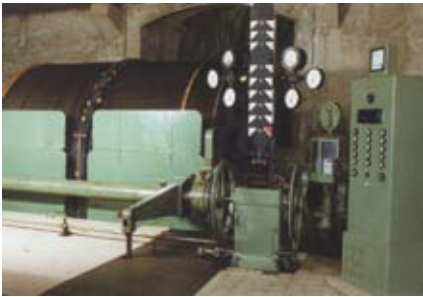
Abb. 99: Neue Richtschachtfördermaschine, Foto aus der Sammlung Heinrich Stöcker
