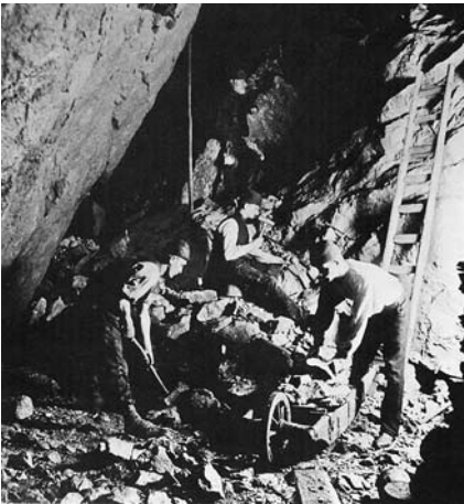
Abb. 74: Firstenstoßbau im Rammelsberg um 1900, Foto aus der Sammlung Heinrich Stöcker
