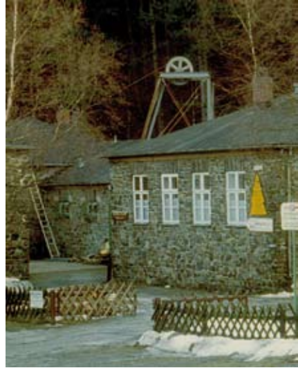
Abb. 122: Hilfsfördergerüst für die Verfüllung des Winkler Wetterschachts 1998, Foto Bernhard Pollak
