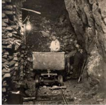
Abb. 110: Firstenstoßbau im Rammelsberg, Foto aus der Sammlung Heinrich Stöcker
