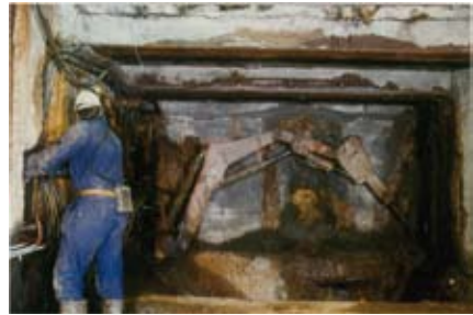
Abb. 114: Volkmar Scholz an den Bedienhebeln für den Hydraulikhammer über der Rolle 1350, Foto Holger Lausch 1998
