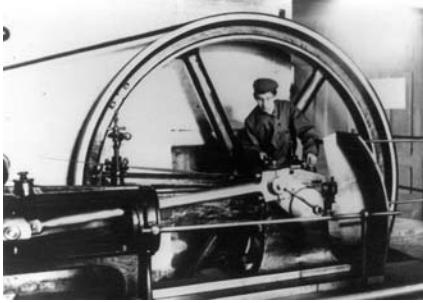
Abb. 71: Dampfmaschine für den Kompressorenantrieb des Kanekuhler Schachtes, Foto aus der Sammlung Heinrich Stöcker
