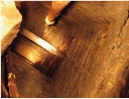
Abb. 59: Blick in den mit Werkstein ausgebauten Serenissimum Tiefsten Schacht, Foto Holger Lausch 1998
