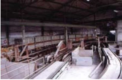
Abb. 112: Wagenumlauf in der oberen Etage des Erzaufbereitungsgebäudes, Foto Holger Lausch 1998
