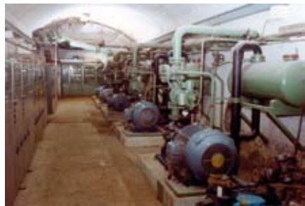
Abb. 119: Sauerwasser-Pumpenraum auf der 9. Sohle Richtschacht, Foto aus der Sammlung Heinrich Stöcker
