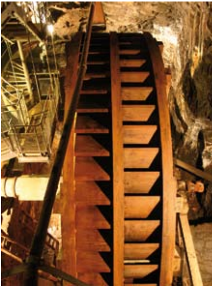
Abb. 57: Röderstollensystem, rekonstruiertes Kehrrad 17 Kanekuhler Schacht
