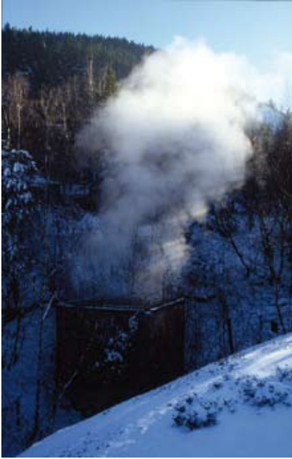
Abb. 118: Dampfwolke über dem Wetteraufhauen durch Kondensation der Wasserdampfbestandteile der ausziehenden Wetter in der kalten Winterluft, Foto Holger Lausch 1998
