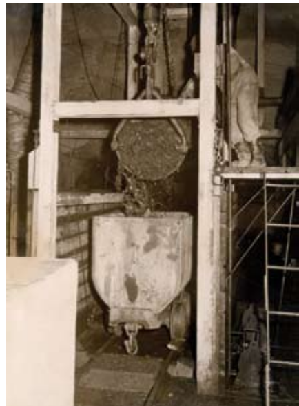
Abb. 105, 106 und 107: Weitererteufen des Rammelsbergsschachtes, Haspel auf der 10. Sohle, Teufkübel beim Füllen und beim Stürzen, Fotos aus der Sammlung Heinrich Stöcker
