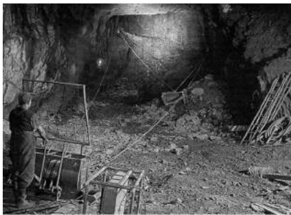
Abbildungen 8 und 9: Wolf-Dreitrommel-Schrapper im Kammerbau und ELBA-Zweitrommel-Schrapper im Pfeilerbau 5 , EBR, 1961 (Fotos aus der Sammlung G. Müller)
