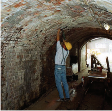
Abbildung 6: Mauerwerkssanierung im Bereich Mundloch Tagesförderstrecke (Foto P. Eichhorn 2005)
