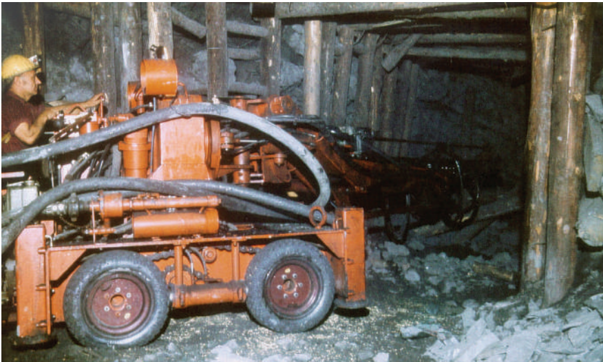
Abbildung 44: ALIMAK-Bohrfahrzeug Typ 141 S 2400 in der 1. Teilsohle EBR 21 (Fotos G. Müller)
