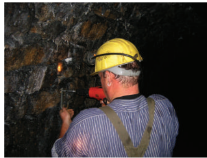
Abbildung 5: Installationsarbeiten für die Beleuchtung der Unteren Gestängestrecke Röderstollen (Foto P. Eichhorn 2005)
