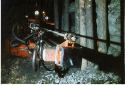
Abbildung 43: ALIMAK-Bohrfahrzeug Typ 141 S 2400 in der 1. Teilsohle EBR (Fotos G. Müller)
