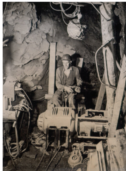
Abbildungen 8 und 9: Wolf-Dreitrommel-Schrapper im Kammerbau und ELBA-Zweitrommel-Schrapper im Pfeilerbau 5 , EBR, 1961 (Fotos aus der Sammlung G. Müller)
