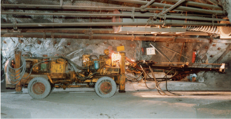
Abbildung 45: ALIMAK/PAUS-Bohrfahrzeug, Querschlag von der Rampe zur 4. Teilsohle (Foto G. Müller, 1988)
