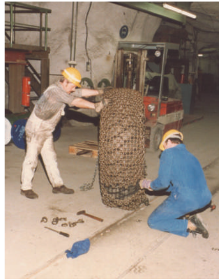
Abbildungen 18 und 19: RUD-Schutzkette. Montage in der EBR-Werkstatt 11. Sohle (Fotos G. Müller, 1988)
