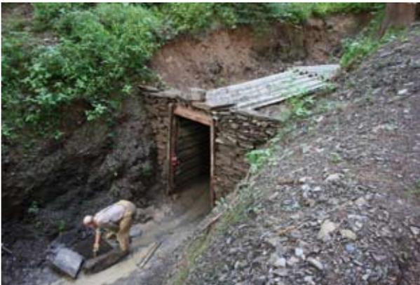
**Abbildung 4.4.t:** Foto fertiggestelltes neues Stollenmundloch mit Verzug dahinter und seitlicher Trockenmauer, vor dem Mundloch arbeitet der Verfasser am Einlaufbauwerk der Drainageröhre. Foto aufgenommen von Astrid Dützer 2014
