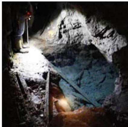
**Abbildung 4.5.h: Holz im abgesoffenen Gesenk, Ostflügel des ersten Querschlags**
