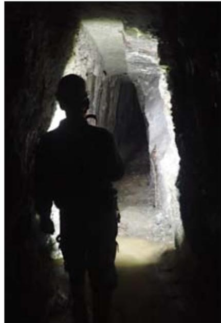
**Abbildung 4.5.f: Robert Helms in einem geschlägelten Stollenbereich, der mit Bohr- und Sprengarbeit deutlich verbreitert wurde**
