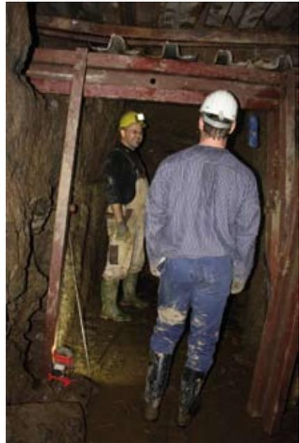
**Abbildung 4.4.v1 bis v4: Beim Stollenaufwältigen in Getriebezimmerung: 1. Karl Sander beim Haufwerkkladen, 2. Karl Sander und Stefan Dützer, 3. Der Verfasser und Stefan Dützer , 4. Olf Sack und Michael Klein unter einem Getriebetürstock. Fotos aufgenommen von Astrid Dützer 2014**
