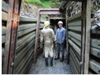
**Abbildung 4.4.s1 und s2:** Foto Einschnittbereich mit Türstöcken und seitlichen Verzugsblechen, dahinter Verstoß von Haufwerk aus der Stollenaufwältigung, im Bild links Olf Sack und rechts Michael Klein. Fotos aufgenommen von Astrid Dützer 2014
